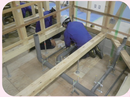
給排水配管作業
