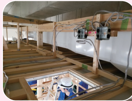
電気配線作業
