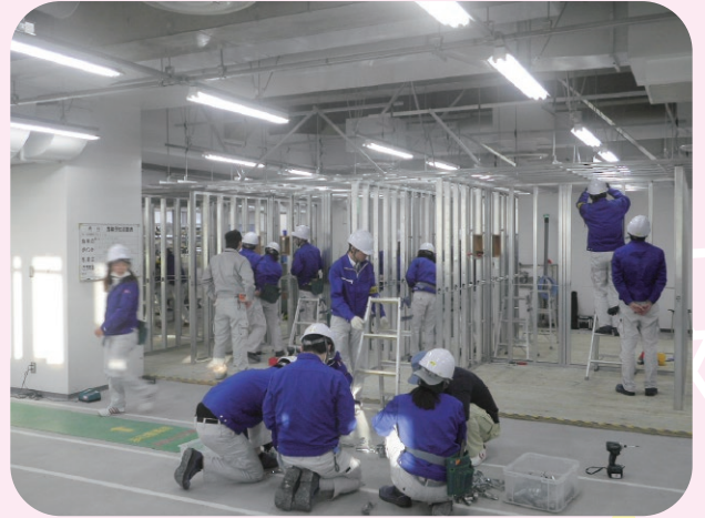
鋼製下地作業
