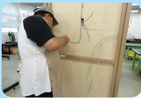
電気工事体験
