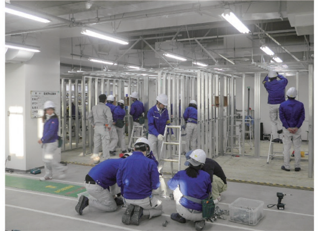
鋼製下地作業
