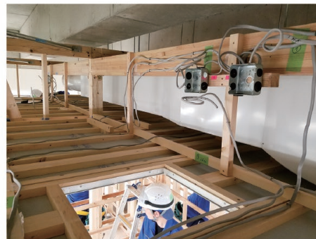
電気配線作業
