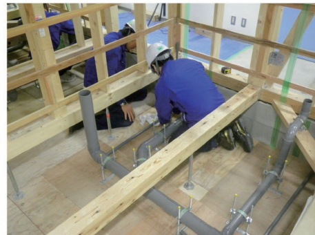
給排水配管作業
