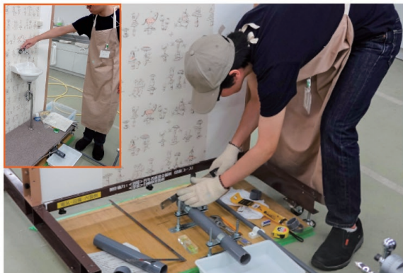
給排水工事体験
