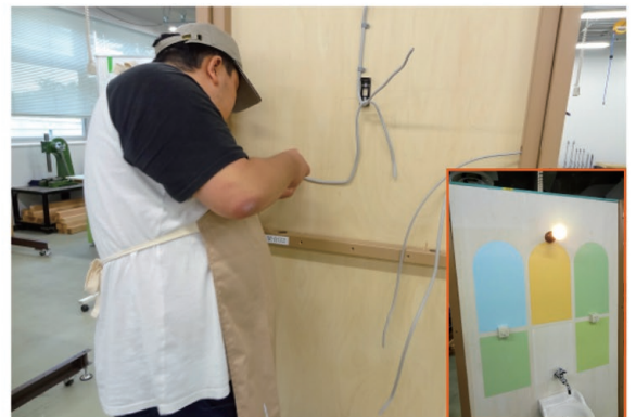
電気工事体験
