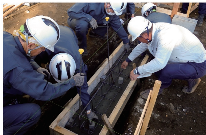
土木作業実習
