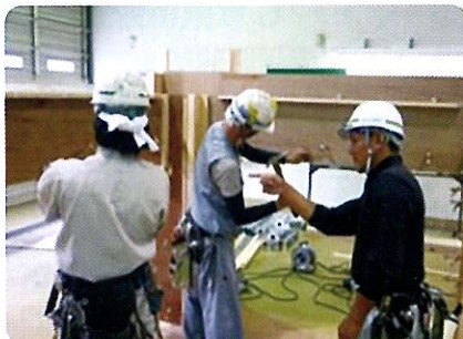
型枠施工実習
