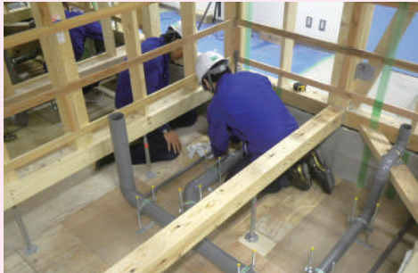
給排水配管作業
