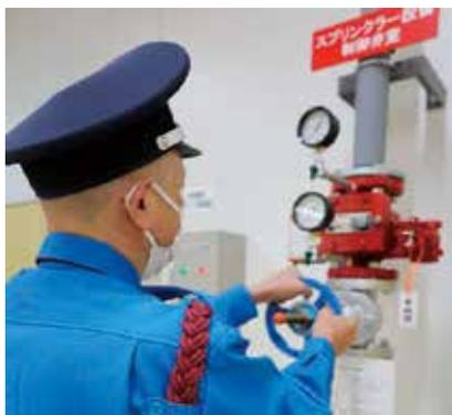
スプリンクラー制御弁操作訓練
