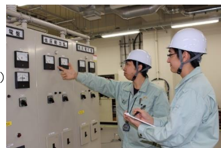
受変電設備の 保守管理 (実習)
