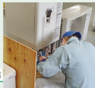
給湯器取付け作業
