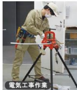
電気工事作業
