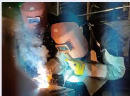
被覆アーク溶接
