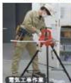
電気工事作業
