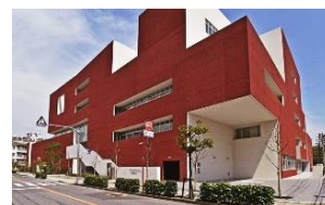
城東職業能力開発センター
