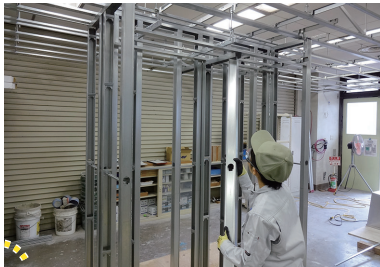
鋼製下地（壁と天井の下地）
