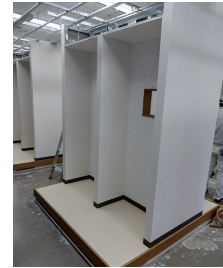
模擬家屋の施工（基礎）
