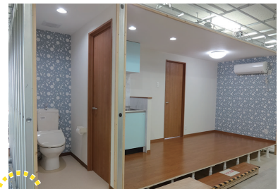
模擬家屋の施工（応用実習）
