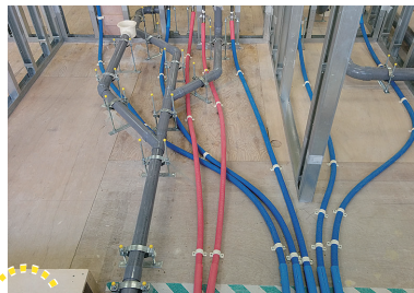
建築設備（配管の施工）
