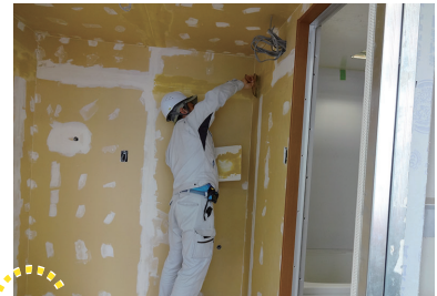
壁の下地処理（パテ処理）
