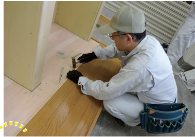
フローリング施工
