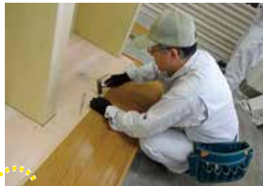
フローリング施工
