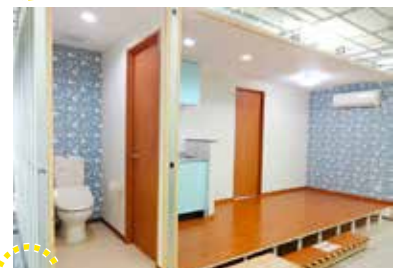
模擬家屋の施工（応用実習）
