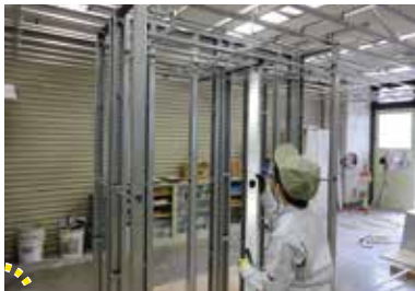
鋼製下地（壁と天井の下地）
