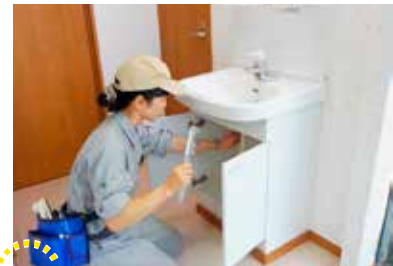
設備の取付け
