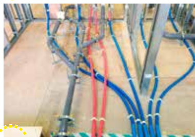
建築設備（配管の施工）
