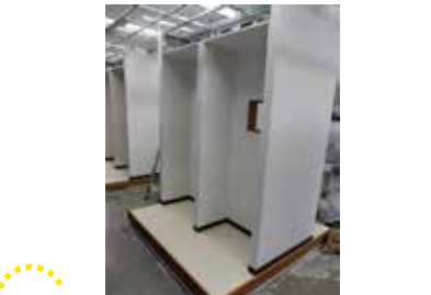
模擬家屋の施工（基礎）
