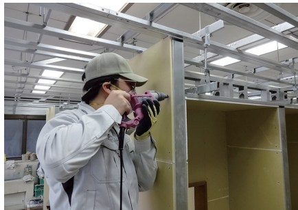
写真②：ボード張り
