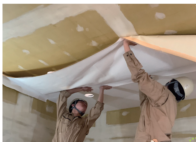
天井仕上げ実習
