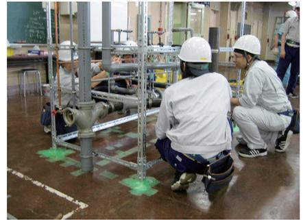
写真③：給排水配管の施工
