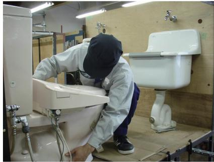
写真②：衛生陶器の取付け
