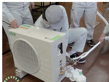
エアコンの取付け
