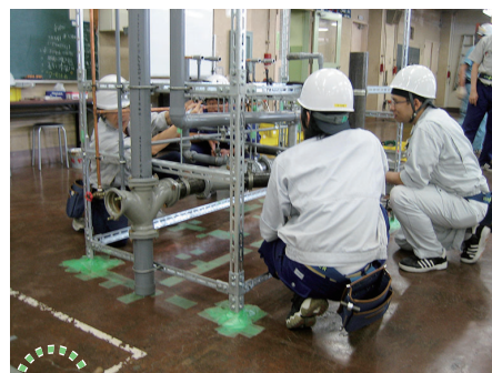
給排水配管の施工
