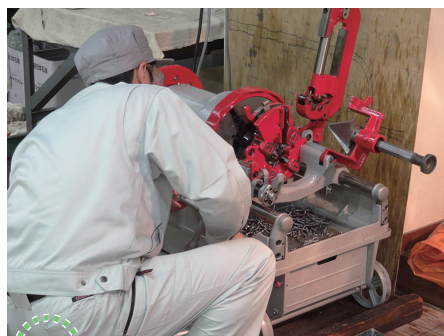
給排水配管の施工
