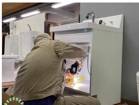
衛生器具の取付け
