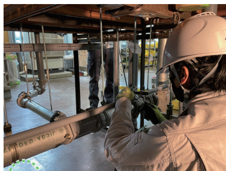
給排水配管の施工
