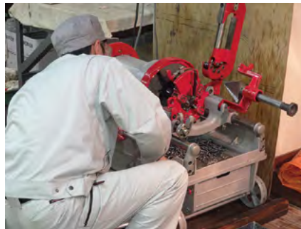
写真⑤：給排水配管の施工
