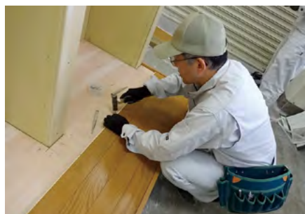
写真⑤：フローリング施工
