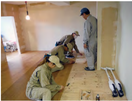
写真⑤：床仕上げ基礎作業
