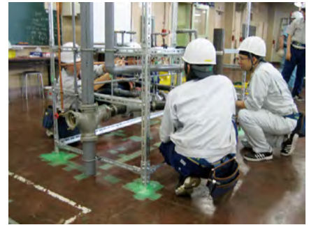
写真③：給排水配管の施工
