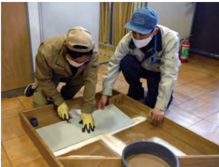
写真④：床仕上げ基礎作業
