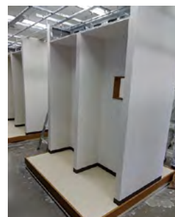
写真⑥：模擬家屋の施工（基礎）
