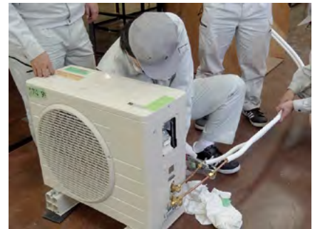
写真⑥：エアコンの取付け
