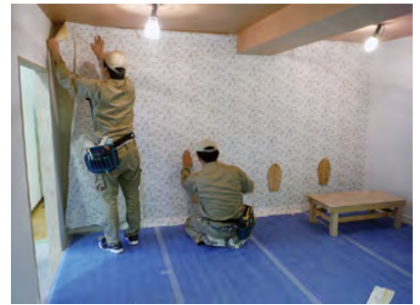
写真③：壁紙張り作業
