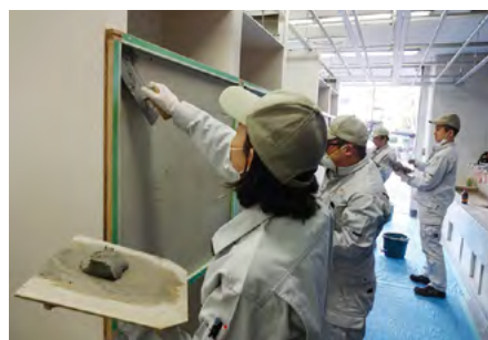
写真⑦：左官・タイル張り
