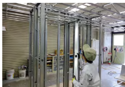
写真①：鋼製下地（壁と天井の下地）
