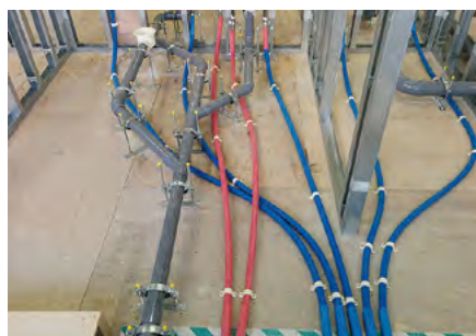
写真⑧：建築設備（配管の施工）
