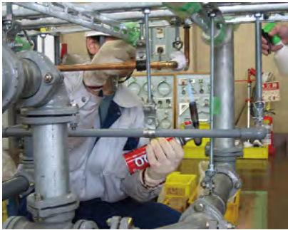
写真①：給排水配管の施工
