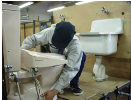
写真②：衛生陶器の取付け
