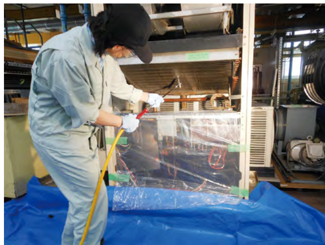
写真②：エアコンのフィルター清掃
