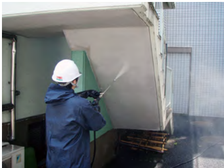
建築塗装実習（高圧水洗浄） 外壁を高圧水洗浄機で清掃しています。
