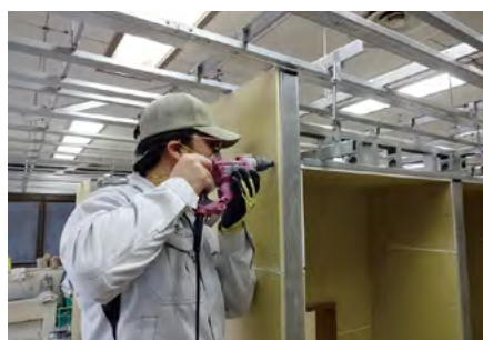
写真②：ボード張り
