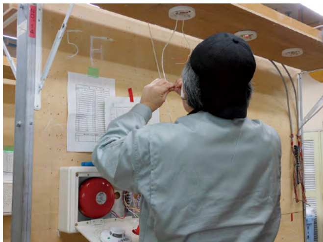
写真①：自動火災報知機の施工実習
