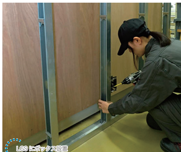
LGSにボックス設置
