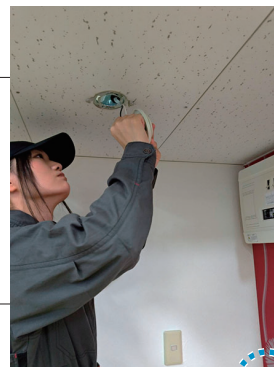
天井に照明器具を設置
