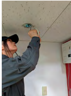
写真⑤：天井に照明器具を設置
