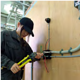
写真④：結線作業
