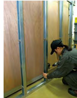
写真⑥：LGSにボックス設置
