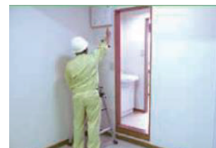
マンション改修施工科
