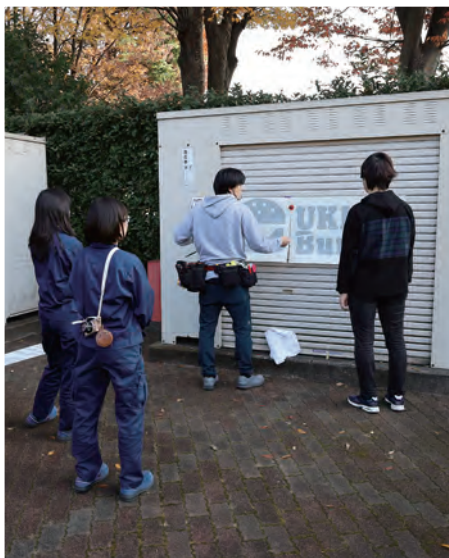
粘着シート施工
