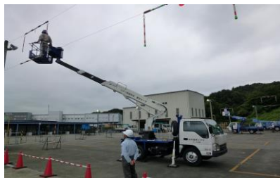
高所作業車運転 技能講習
