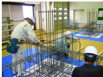
鉄筋施工作業
