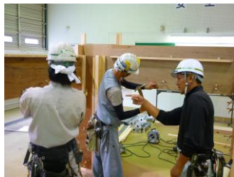
型枠施工作業
