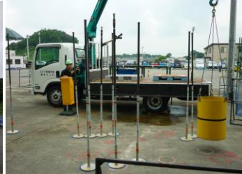
小型移動式クレーン 運転技能講習
