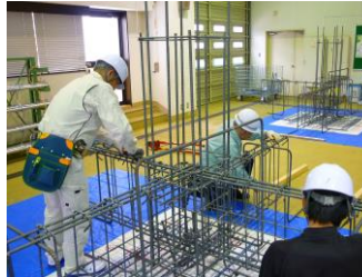
鉄筋施工作業
