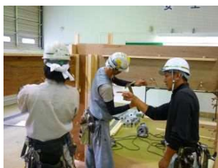
型枠施工作業
