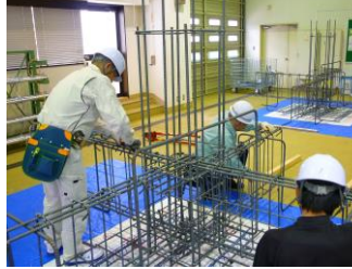
鉄筋施工作業
