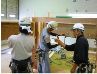
型枠施工作業
