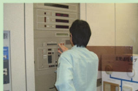
火災報知設備点検実習
