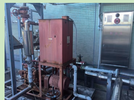
消火栓・スプリンクラー設備実習
