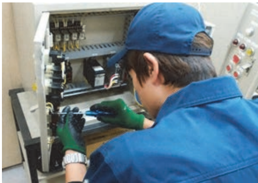
制御盤配線実習
