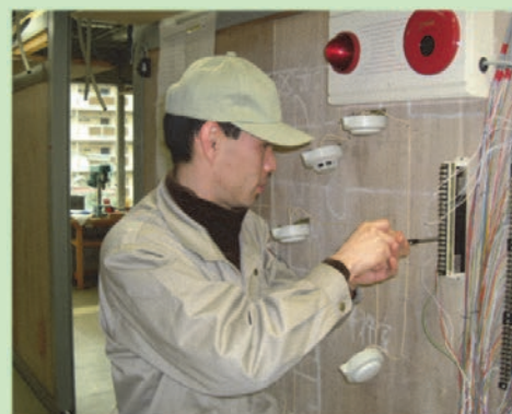
自動火災報知設備工事実習
