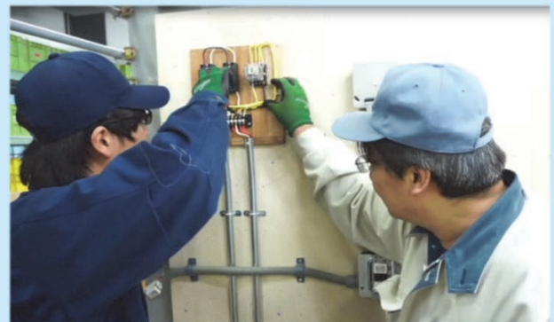
電気工事作業
