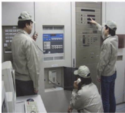
実習の様子(防災センター業務)
