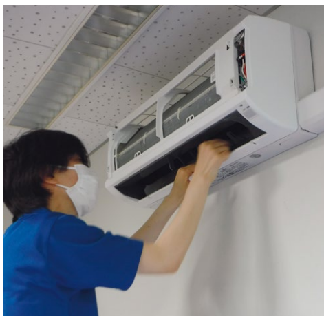
エアコン清掃作業
