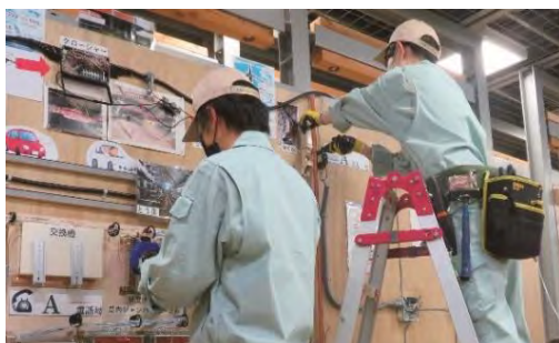
電話回線工事の実習
