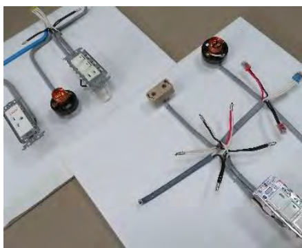
第二種電気工事士技能試験対策の練習課題
