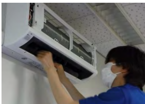
エアコン清掃作業
