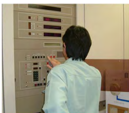
火災報知設備点検実習
