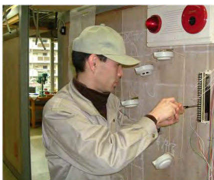
自動火災報知設備工事実習
