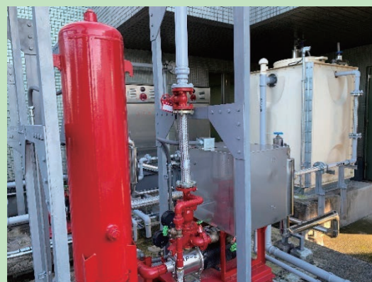
消火栓・スプリンクラー実習設備
