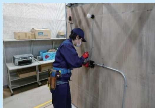
電気工事作業
