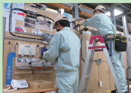
電話回線工事の実習
