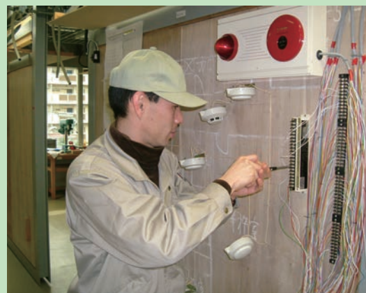
自動火災報知設備工事実習
