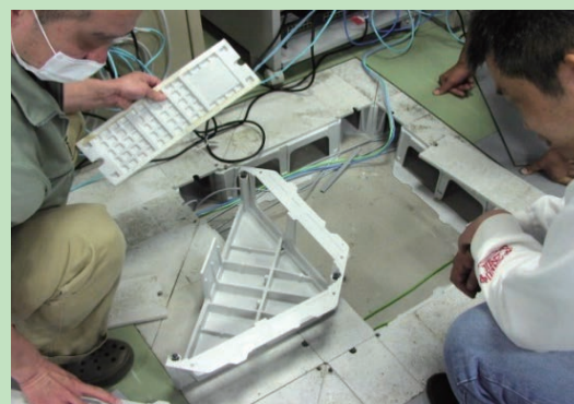
床配線の確認
