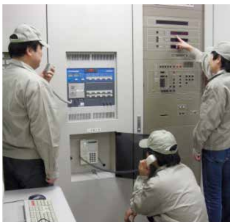
実習の様子(防災センター業務)
