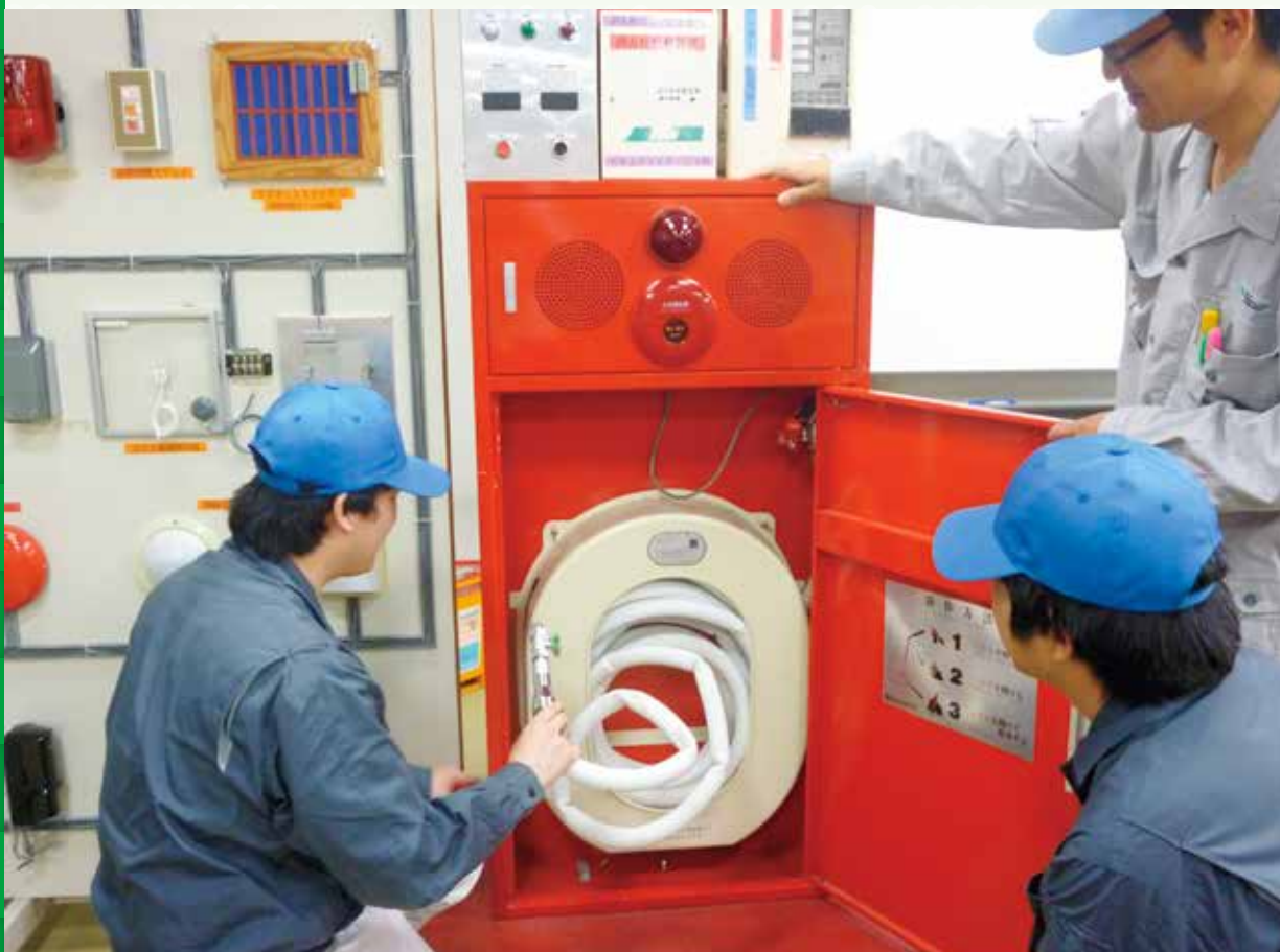
防災設備の点検作業の様子
