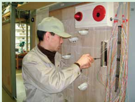
自動火災報知設備工事実習
