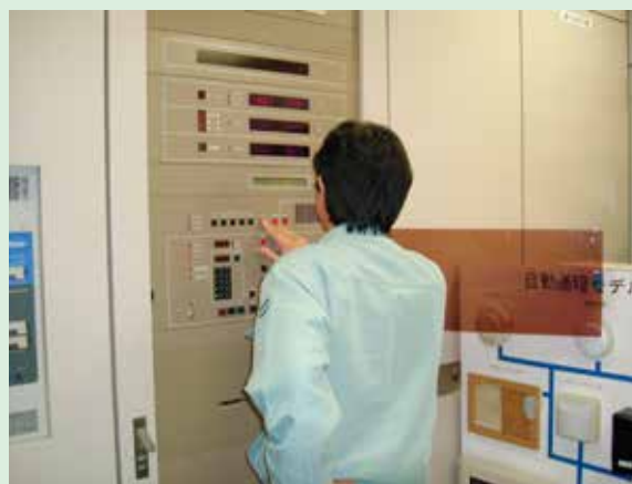
火災報知設備点検実習
