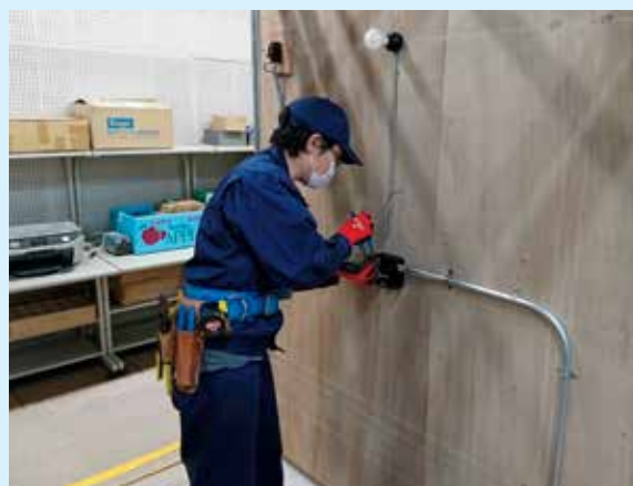
電気工事作業
