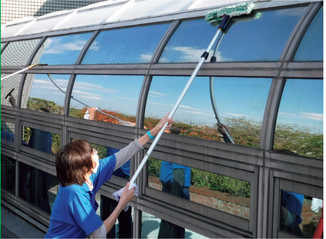
ガラスの清掃作業
