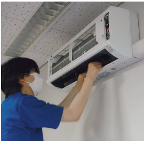
エアコン清掃作業
