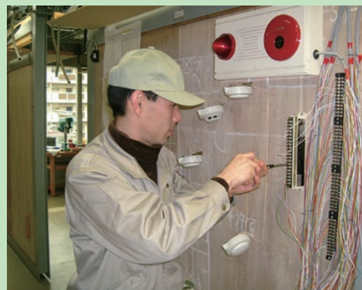
自動火災報知設備工事実習
