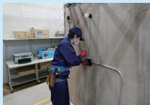
電気工事作業
