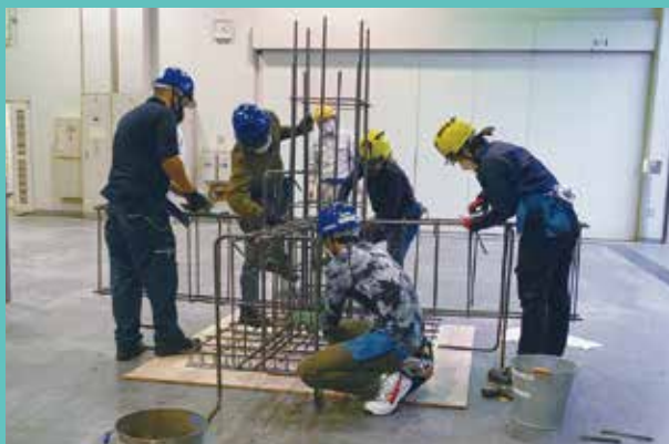
鉄筋施工実習
