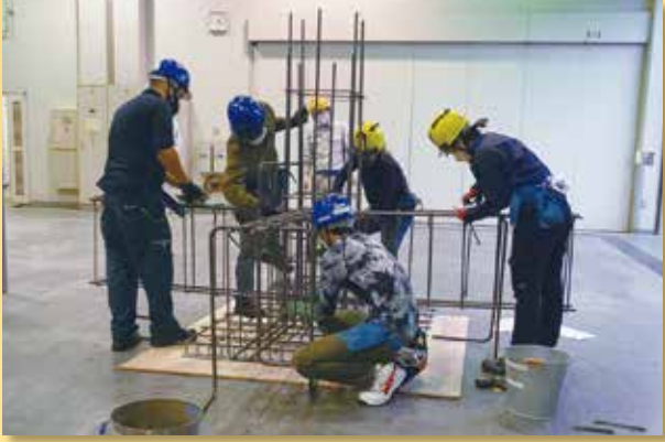
鉄筋施工実習
