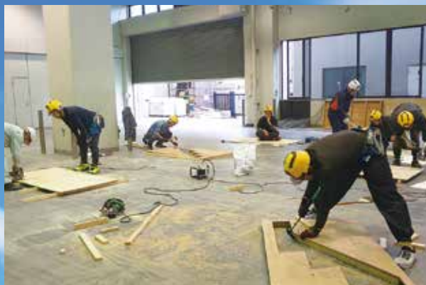
型枠施工実習
