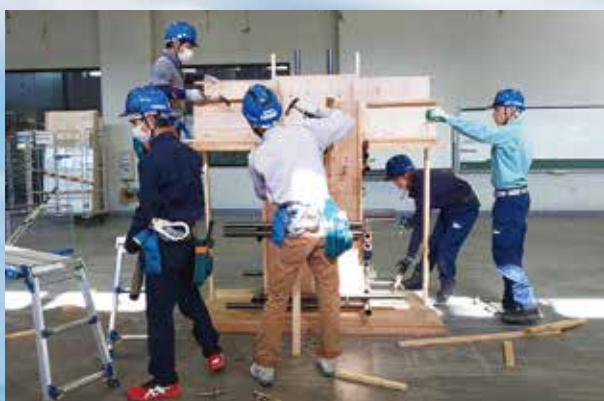
型枠施工実習
