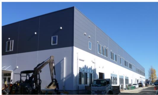
※新築校舎外観：令和8年竣工前 令和7年12月18日撮影
