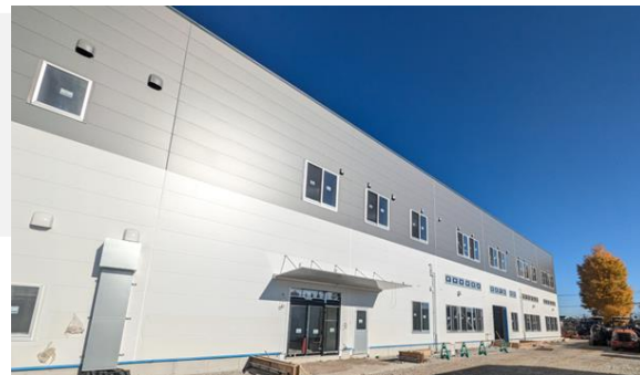
※新築校舎外観：令和8年竣工前 令和7年12月10日撮影
