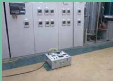
受変電設備作業
