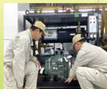
冷凍機分解整備
