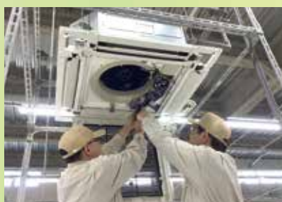
業務用空調機取付
