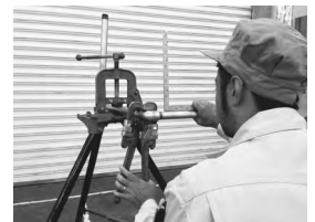
▲配管(配管接続作業)
