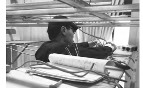
▲電気工事(天井配線作業)
