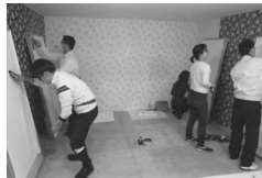
▲上下左右がずれないように、慎重にクロスを貼ります
