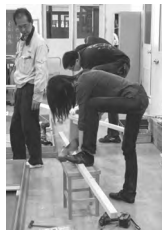
▲根太をのこぎりで切断します
