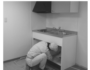
▲マンション改修施工
